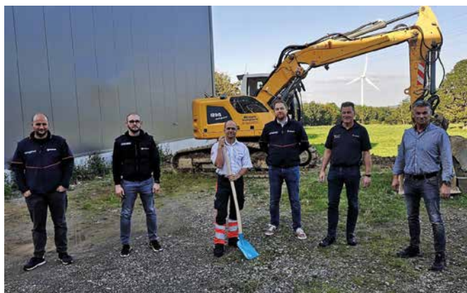
Beginn der Baumaßnahmen war im September Foto: Karl-Heinz Hoffmann
